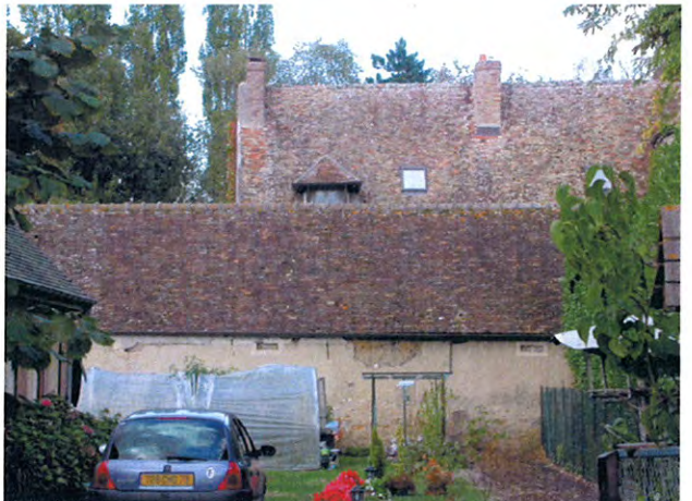
Bâti traditionnel : belles toitures
