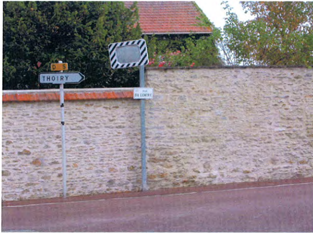
Mur rue du Centre à l'entrée du bourg
