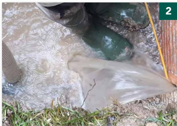
Collecteur de drainage en argile rouge mis au jour lors d'une fouille intermédiaire. Le jet d'eau est dû au fait que la conduite est encore bouchée à ce moment-là.
